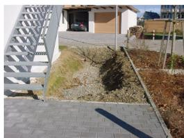
Grundstücksflächen, von denen Niederschlagswasser über eine **Sickermulde**, einem **Mulden-Rigolensystem** oder einer **vergleichbaren Anlage** mit **gedrosseltem Ablauf** oder **mit Notüberlauf** den öffentlichen Abwasseranlagen zugeführt wird, werden mit dem **Faktor 0,1** berücksichtigt.
